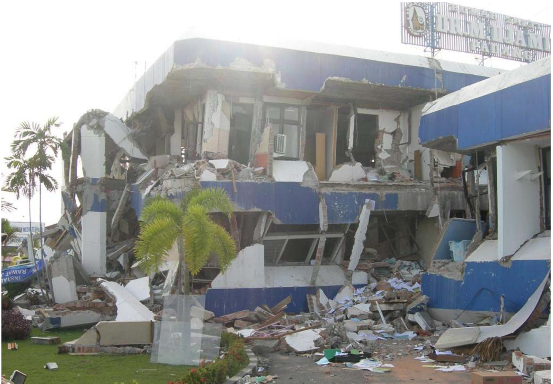
Rumah Sakit yang Roboh/Collapse (Padang 2009)
