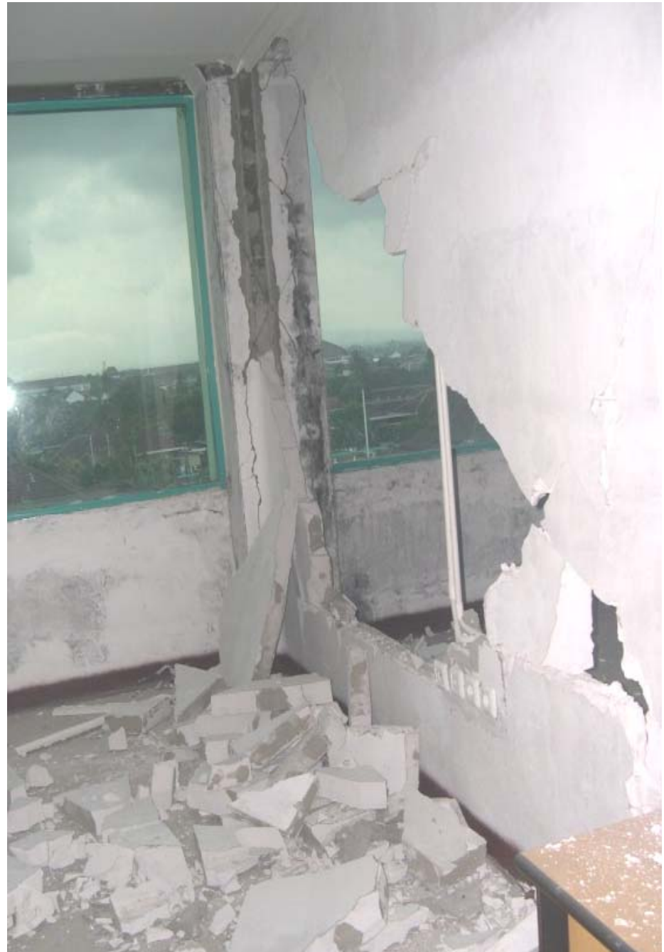
Kerusakan dinding (Yogyakarta 2006)
